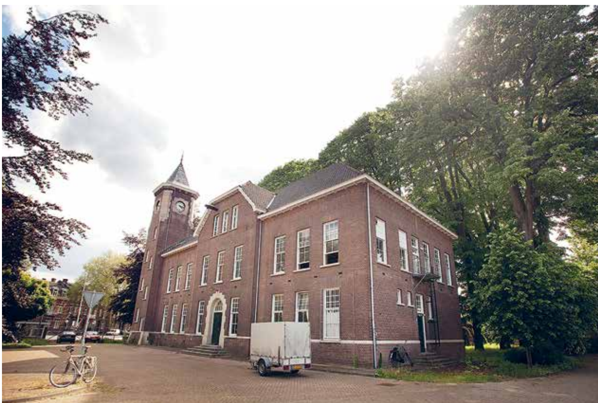
Hoofdgebouw, monumentaal pand dat niet wordt afgebroken
