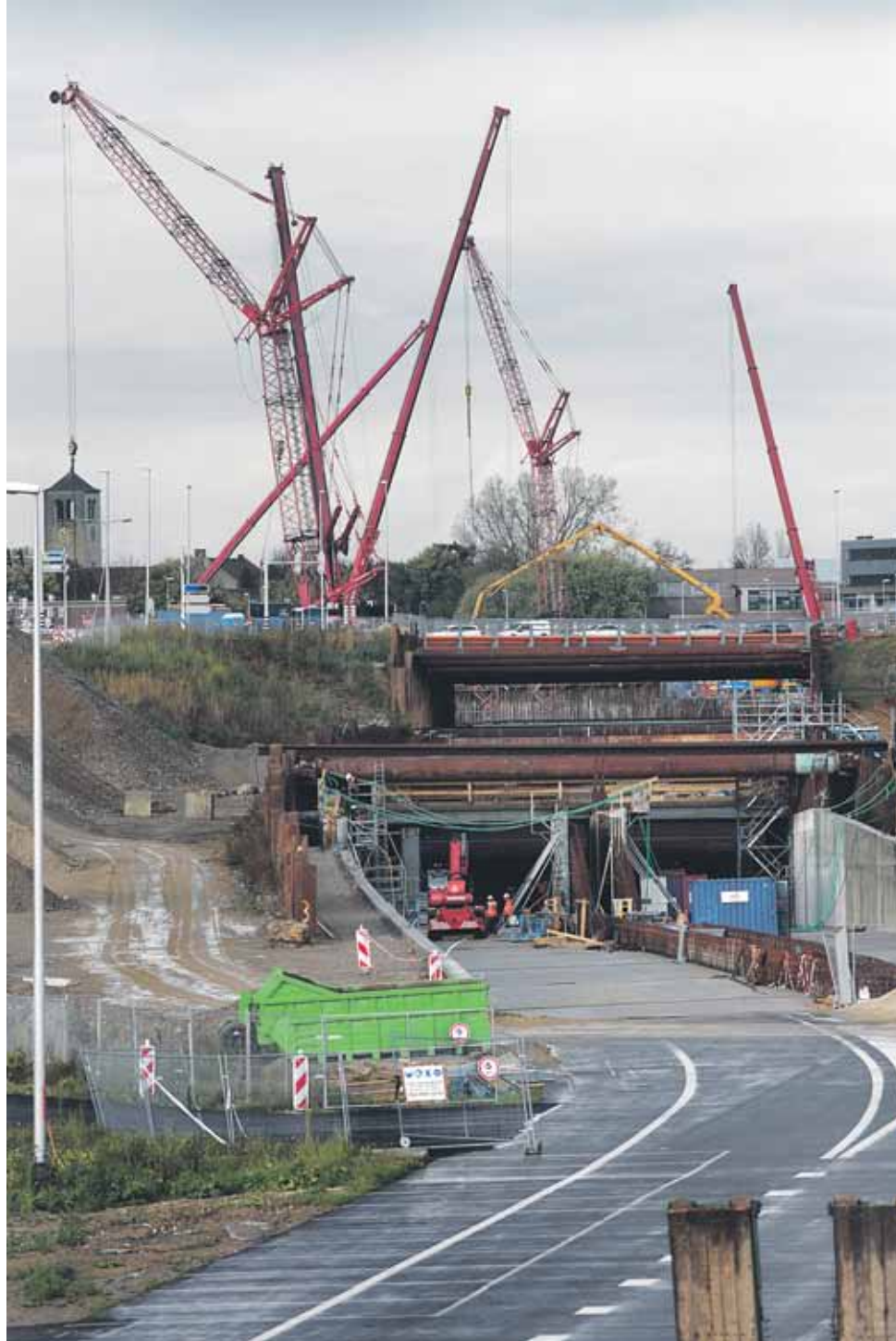
A2, tunnelmonden aan de zuidkant Foto: Joey Roberts
