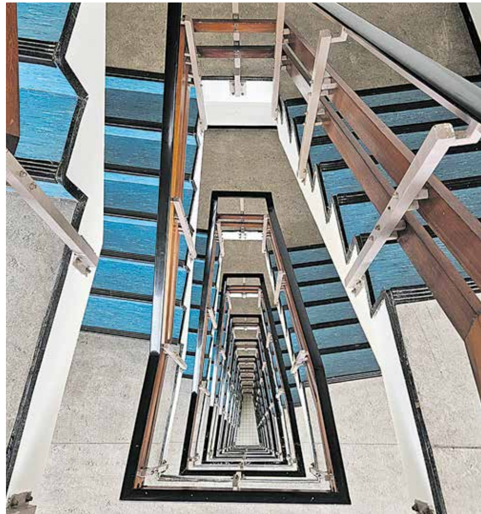
Het trappenhuis van de ARCH studentenflat.
