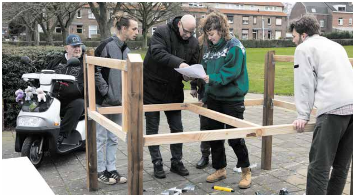
De bouw van een kippenhok in 2020 Foto: Loraine Bodewes
